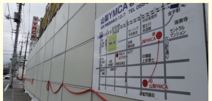
旧会館は取り壊し工事が始まりました
